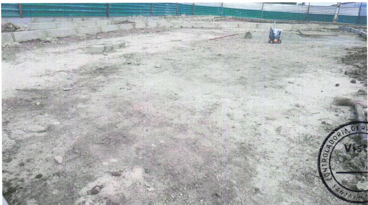
Foto 02 – LIMPEZA MANUAL DO TERRENO (C/ RASPAGEM SUPERFICIAL)
