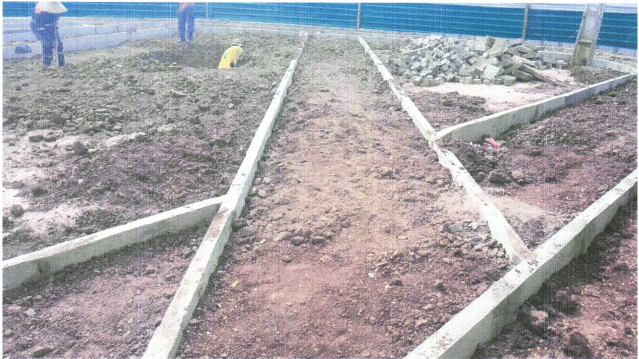
Foto 13 - GUIA (MEIO-FIO) CONCRETO, MOLDADA IN LOCO EM TRECHO RETO COM EXTRUSORA, 13 CM BASE X 22 CM ALTURA. AF_06/2016
