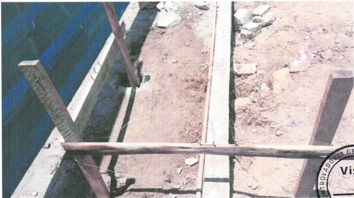
Foto 06 - LOCAÇÃO CONVENCIONAL DE OBRA, UTILIZANDO GABARITO DE TÁBUAS CORRIDAS PONTALETADAS A CADA 2,00M - 2 UTILIZAÇÕES. AF_10/2018
