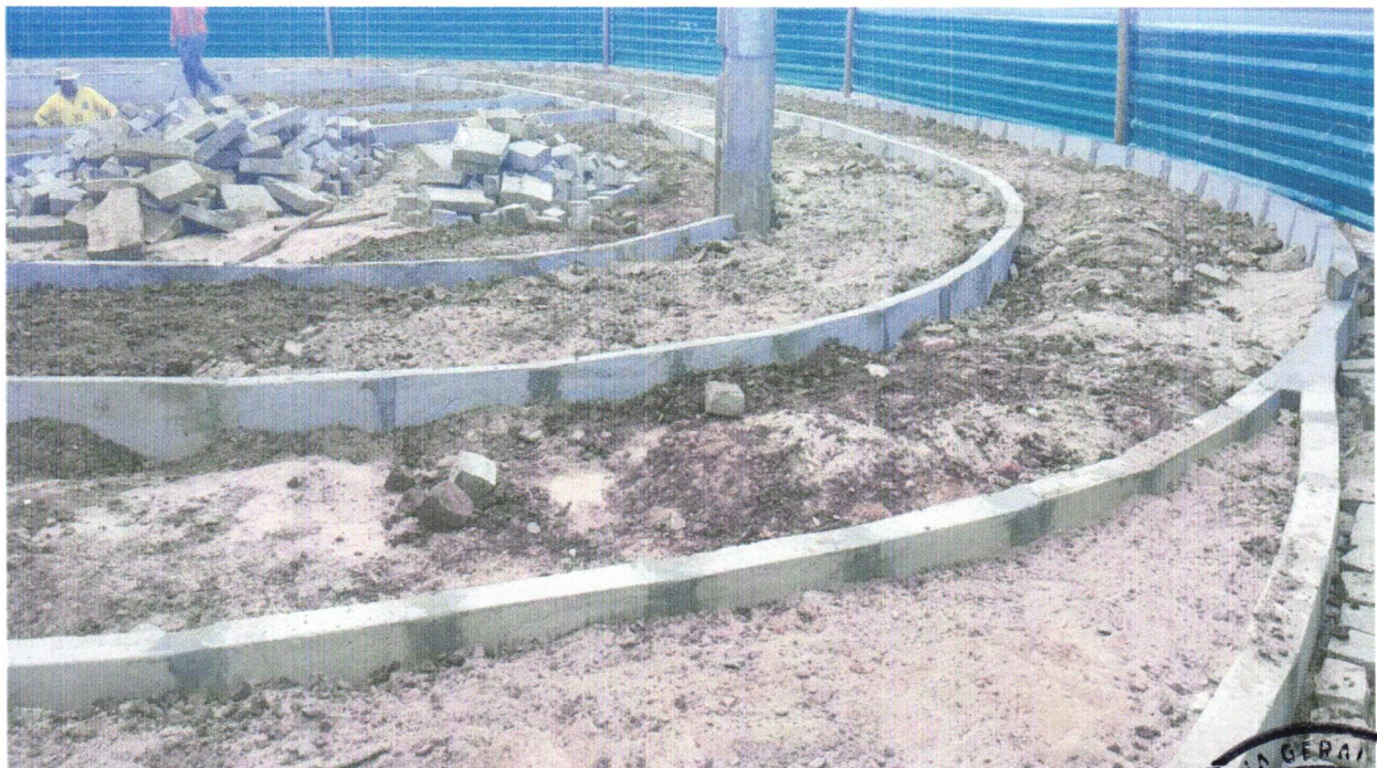
Foto 14 - GUIA (MEIO-FIO) CONCRETO, MOLDADA IN LOCO EM TRECHO RETO COM EXTRUSORA, 13 CM BASE X 22 CM ALTURA. AF_06/2016
