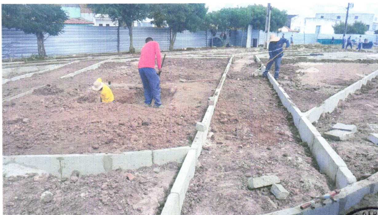
Foto 12- GUIA (MEIO-FIO) CONCRETO, MOLDADA IN LOCO EM TRECHO RETO COM EXTRUSORA, 13 CM BASE X 22 CM ALTURA. AF_06/2016
