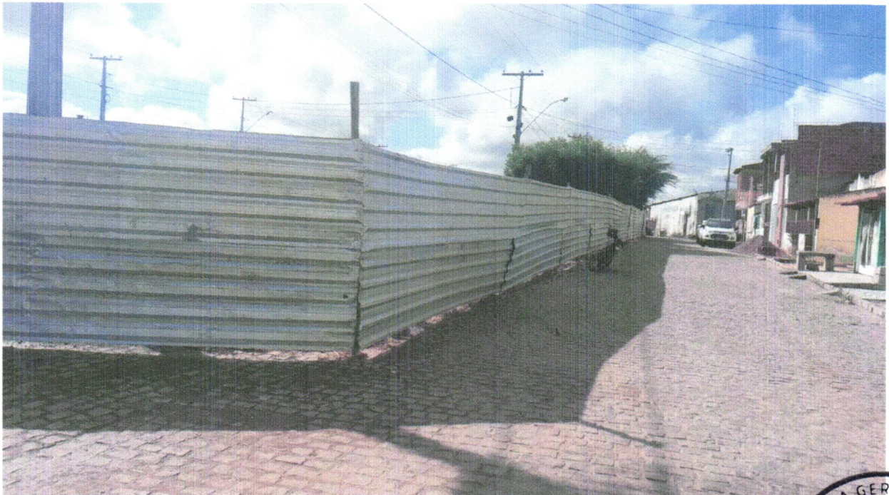
Foto 04 – TAPUME COM TELHA METÁLICA. AF_05/2018
