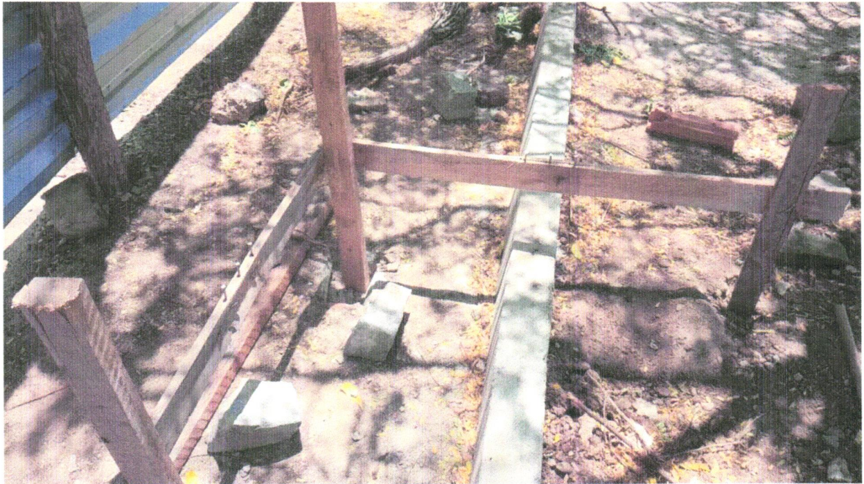
Foto 05 - LOCAÇÃO CONVENCIONAL DE OBRA, UTILIZANDO GABARITO DE TÁBUAS CORRIDAS PONTALETADAS A CADA 2,00M - 2 UTILIZAÇÕES. AF_10/2018
