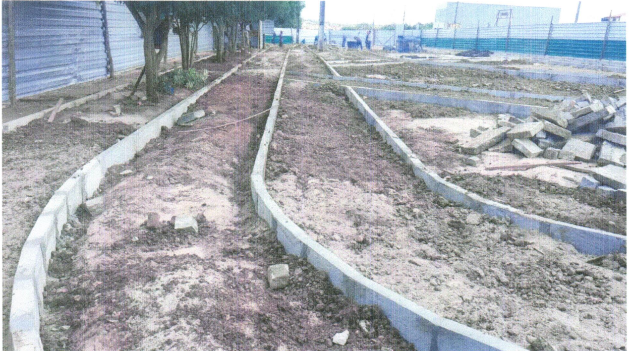
Foto 09 - ASSENTAMENTO DE GUIA (MEIO-FIO) EM TRECHO RETO, CONFECCIONADA EM CONCRETO PRÉ-FABRICADO, DIMENSÕES 100X15X13X30 CM (COMPRIMENTO X BASE INFERIOR X BASE SUPERIOR X ALTURA), PARA VIAS URBANAS (USO VIÁRIO). AF_06/2016
