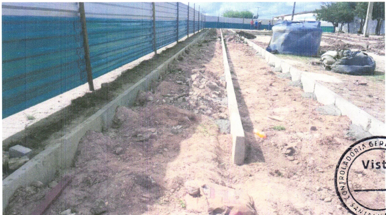
Foto 10 - ASSENTAMENTO DE GUIA (MEIO-FIO) EM TRECHO RETO, CONFECCIONADA EM CONCRETO PRÉ-FABRICADO, DIMENSÕES 100X15X13X30 CM (COMPRIMENTO X BASE INFERIOR X BASE SUPERIOR X ALTURA), PARA VIAS URBANAS (USO VIÁRIO). AF_06/2016
