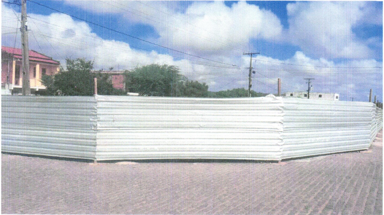
Foto 03- TAPUME COM TELHA METÁLICA. AF_05/2018
