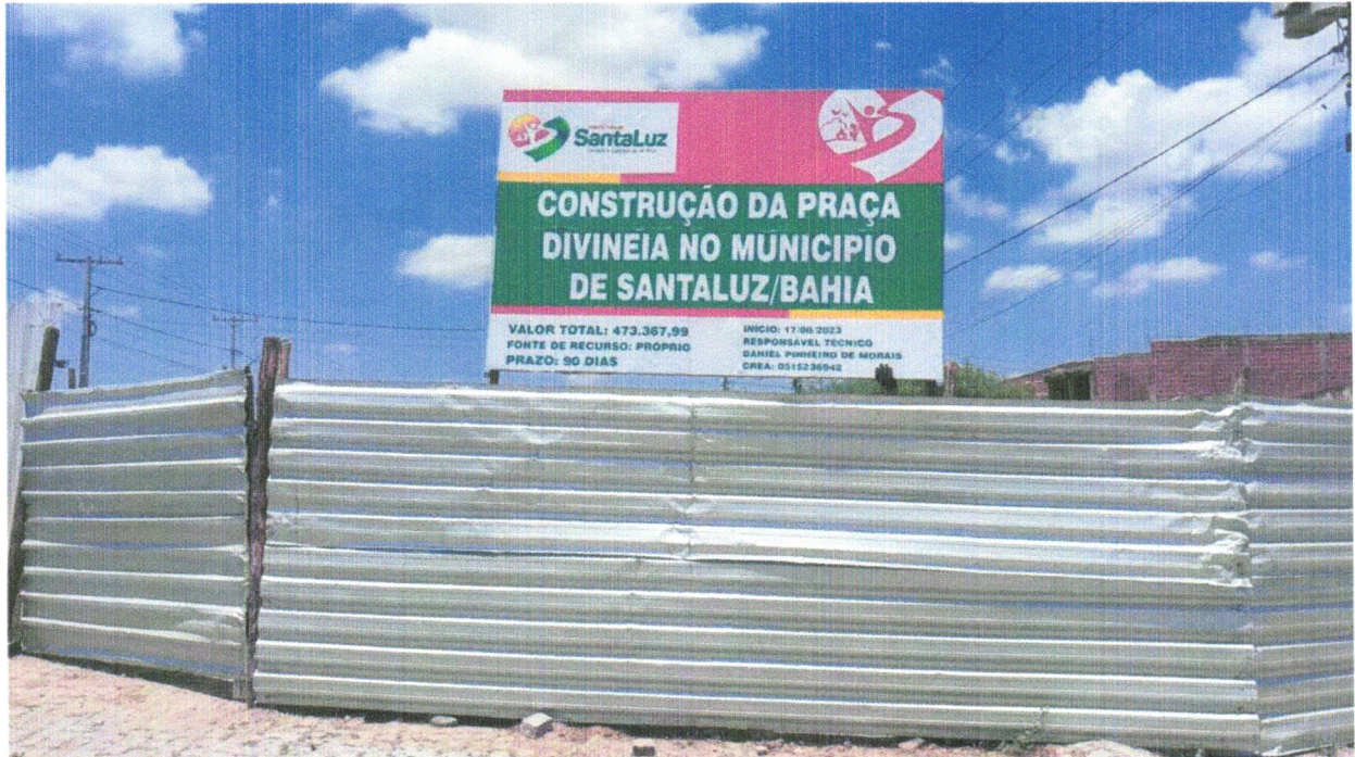
Foto 01 - PLACA DE OBRA EM CHAPA DE AÇO GALVANIZADO
